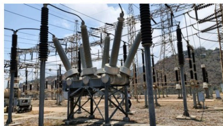
Imagen de los Interruptores Existentes.
